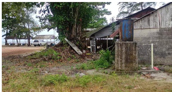
Gambar 3. Kondisi eksisting letak penampungan air hujan, air bersih, dan septic tank pantai Pukan
